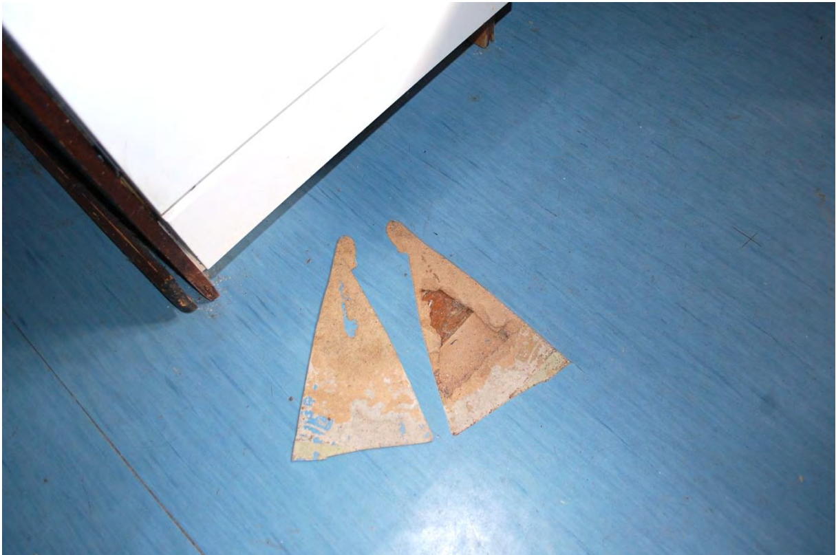
Bortskuren del av linoleummatta i kök för undersökning av golv. Trägolvet skymtar under masonit-täckning.
