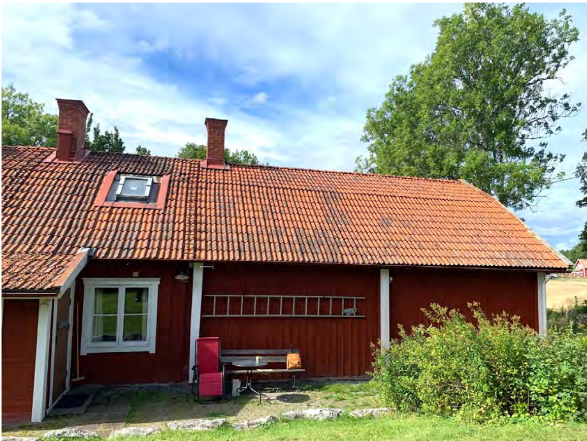
Västra fasaden, norra delen.
