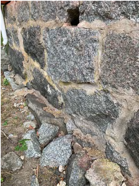
Del av stengrund som fallit av, troligen orsakat av frost.
