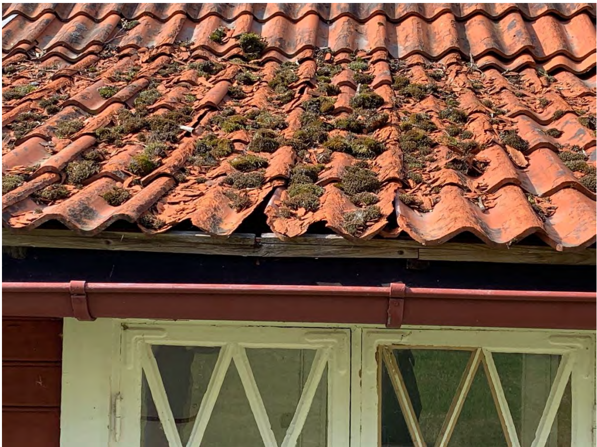
Spjälkat taktegel över farstu, troligen orsakat av frost.
