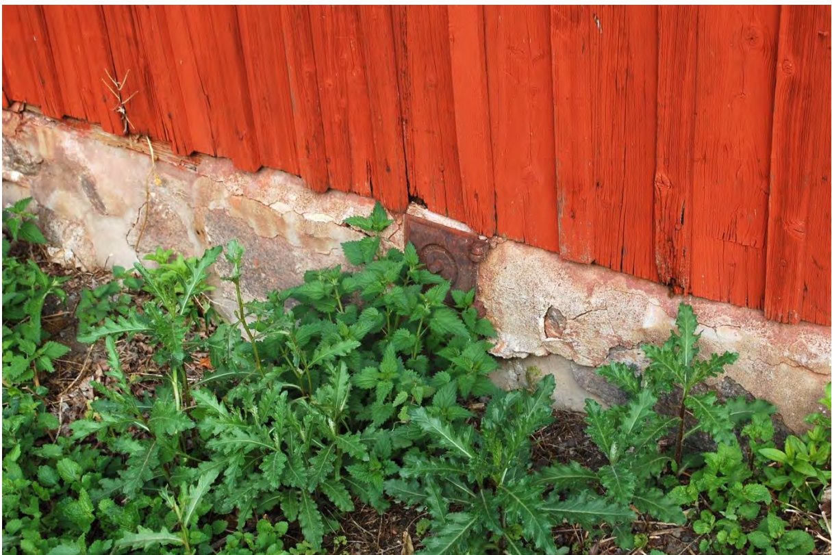
Växtlighet som bör rensas bort nära husgrund vid södra gaveln.
