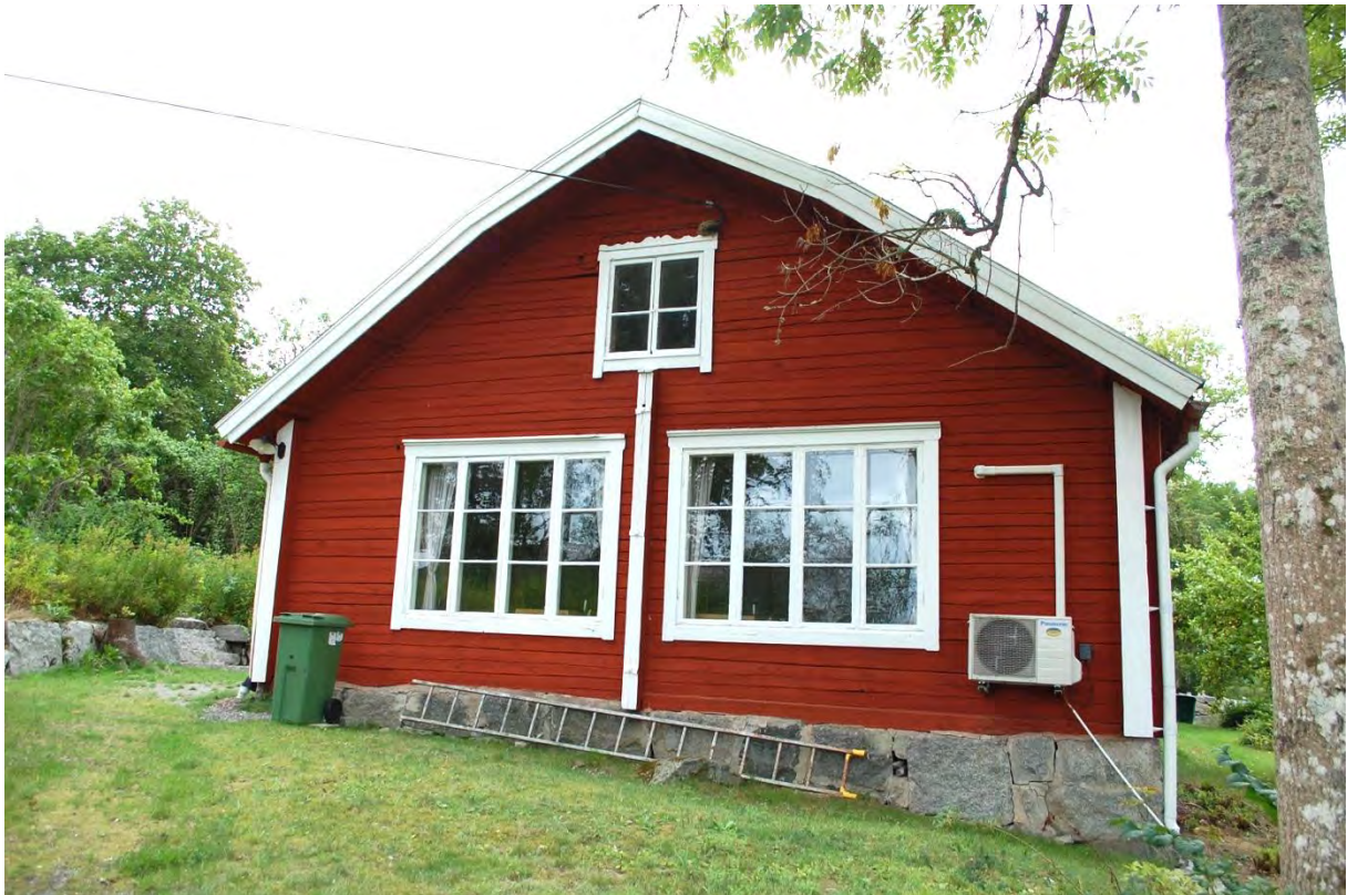
Norra gaveln med fönsterpartier.
