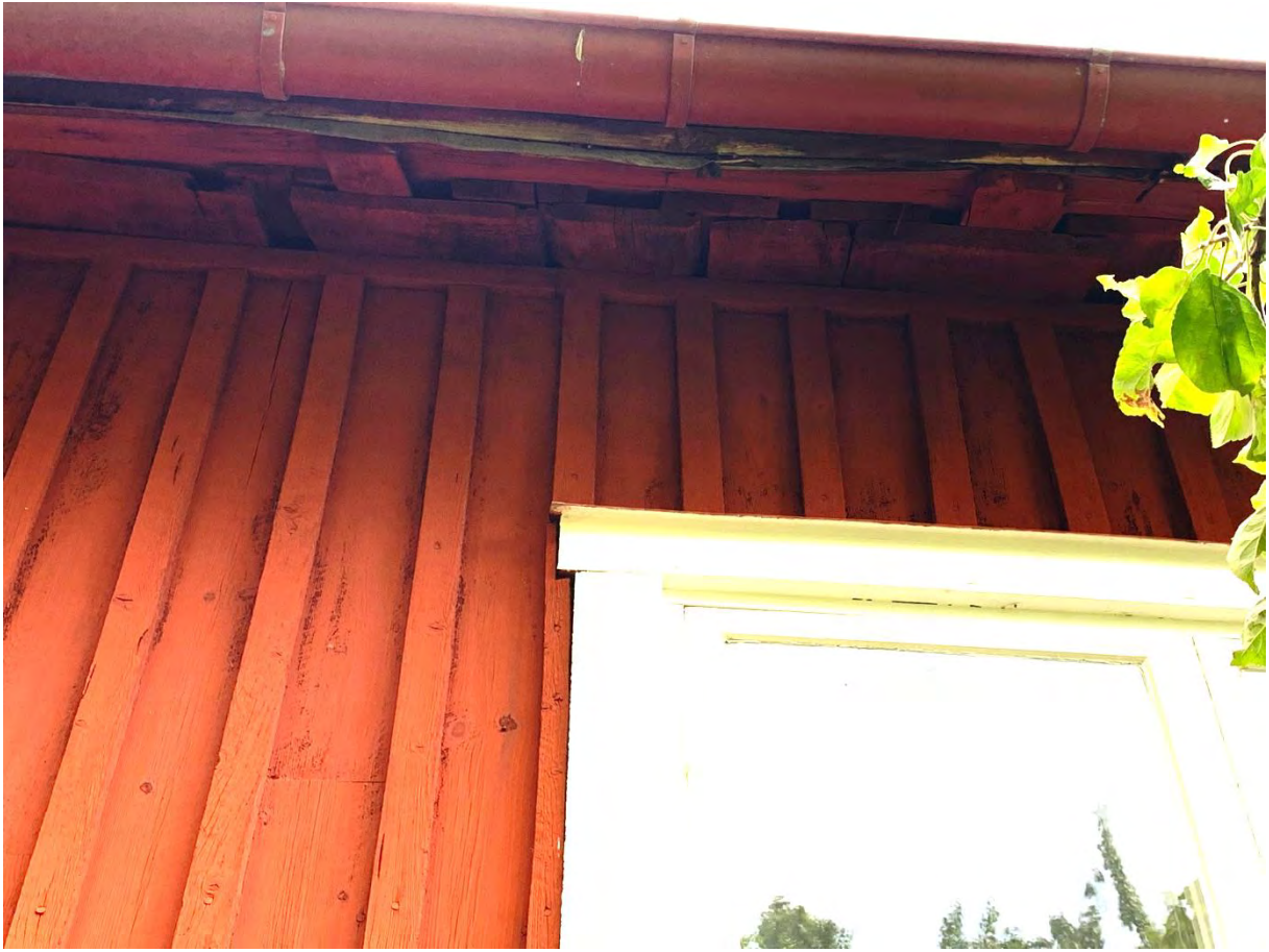
Bågnande takfotsläkt på östra fasaden, södra delen.
