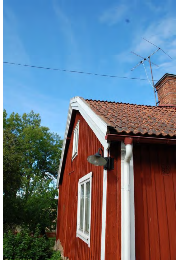
Övre takdel som bågnar vid vindskiva. Här ser man även rost på vattplåten.
