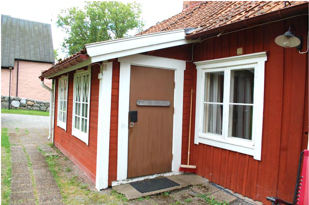
Norra delens entré med ytterdörr i karosseripanel. I bakgrunden skymtar Haga kyrka.
