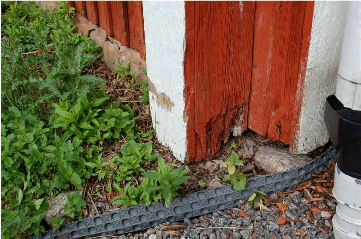
Knutlåda på södra fasaden där nederdelen angripits av röta.
