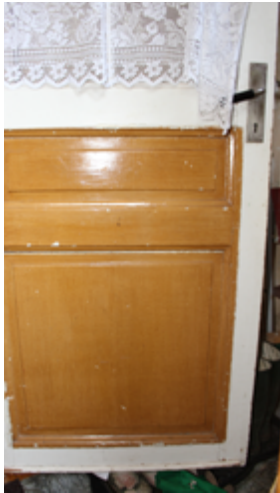
Tv. Glasad spegeldörr mellan tillbyggd hall och äldre kök.
